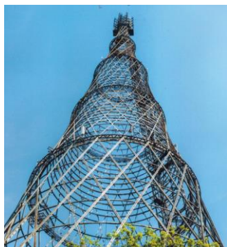
Рис.5. Сетчатые конструкции В.Г.Шухова: а – радиобашня на Шаболовке; б – фрагменты перекрытия здания ГУМа (г.Москва)
