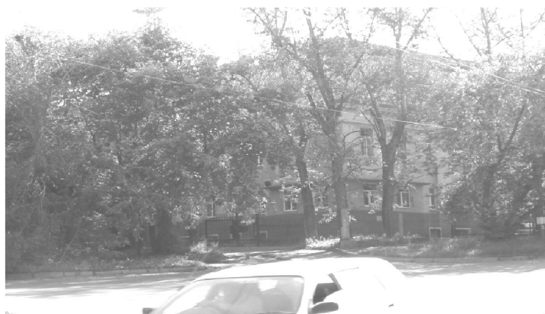
Рисунок 22. Междугородняя телефонная станция.
